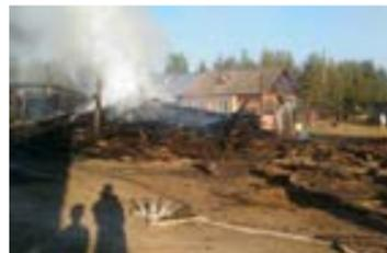
В ходе осмотра места пожара было установлено, что стайка и навес для сена полностью уничтожены огнем, рядом стоящая баня имеет следы сильного обугливания по всей площади, кровля полностью выгорела, произошло выгорание и обрушений одной из стен.
