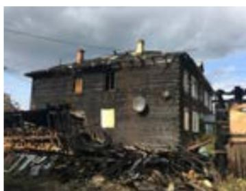
На момент прибытия первого пожарного подразделения было видно, открытое горение надворных построек на всей площади, так же горела смежная стена дома №13 и карниз кровли. Руководителем тушения пожара было подано 6 ствола «РС-50» а так же 1 лафетный ствол на тушение. Пожар был ликвидирован в 16 час 57 мин, на площади 187 кв.м.
