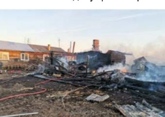
та, постройки квартиры № 2 ул. Школьная – баня, дощатый навес. Пострадали пластиковые окна дома Наиболее сильное термическое повреждение имеет баня квартиры № 1 по ул. Лесная, об этом свидетельствует полное выгорание кровли, потолочного перекрытия, частичное выгорание брусковых стен.
